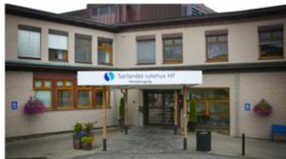
Flekkefjord sykehus HF. Foto: NTB Scanpix. Opplysningsvesenistatistikken (OBS) viser at det er 1000 sykehusbedrifter i Norge.
